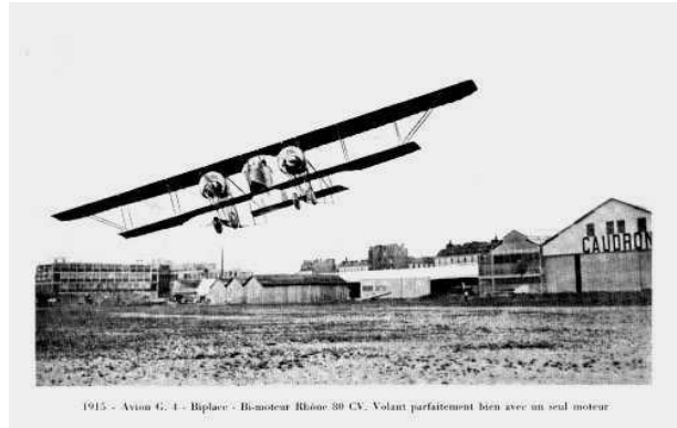
1915 - Avion G. 4 - Biplane - Bi-moteur Rhône 80 CV. Volant parfaitement bien avec un seul moteur
